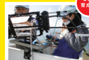
光ケーブル接続作業 わたしだってこんな作業が一人で出来るようになりました。
